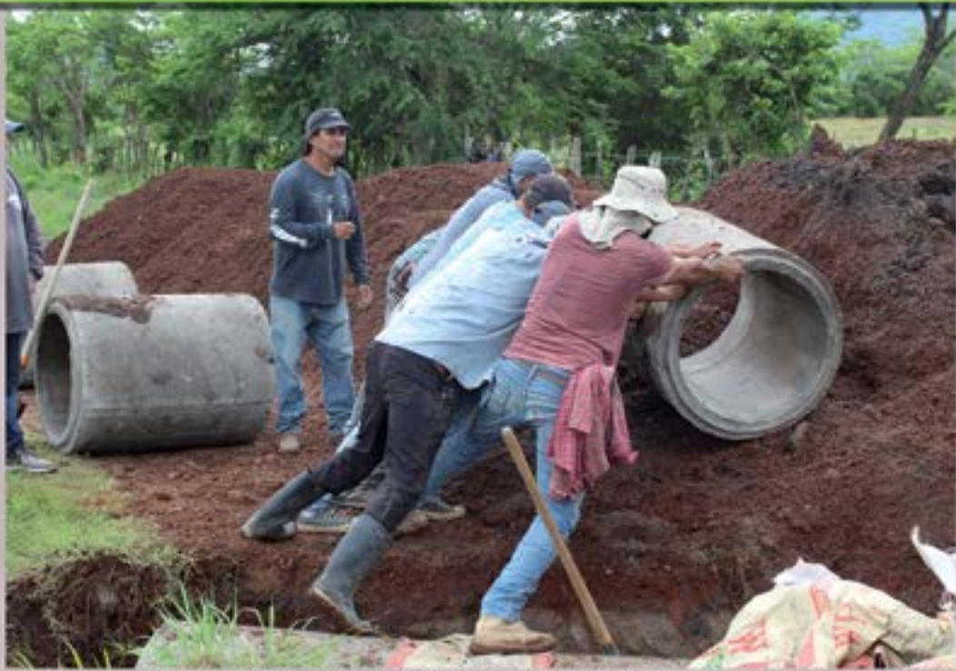
INSTALACION DE TUBERIA DE CONCRETO PARA DESAGUE DE AGUAS LLOVEDIZAS CALLE DE SAN PATRICIO AL TEMPISQUE
